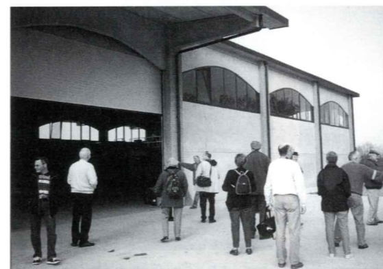
Le nouveau bâtiment
